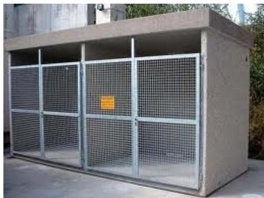
*Figure 7. Stockage extérieur des bouteilles de gaz*
