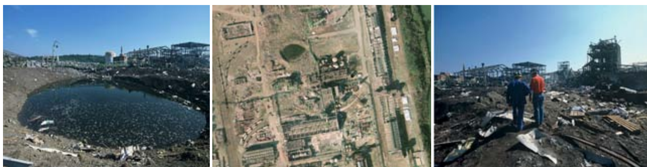
Conséquences de la catastrophe AZF : Cratère, vue aérienne et dégâts après l'explosion.
